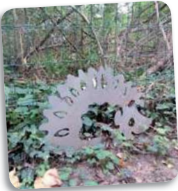
Passage à faune en forme de hérisson dans un grillage
